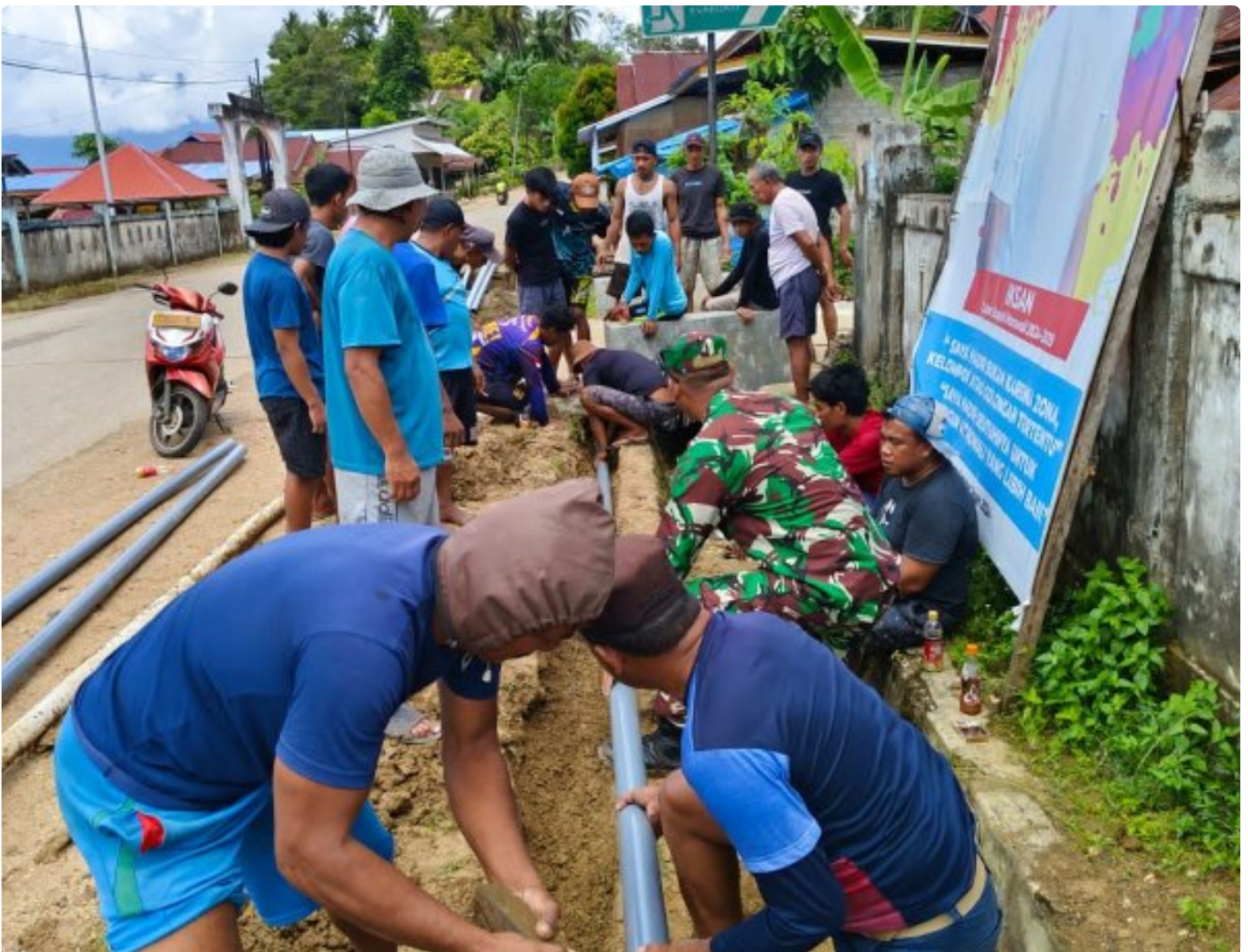
Proses pemasangan pipa air bersih di bantu Babinsa 1311-02/BS
